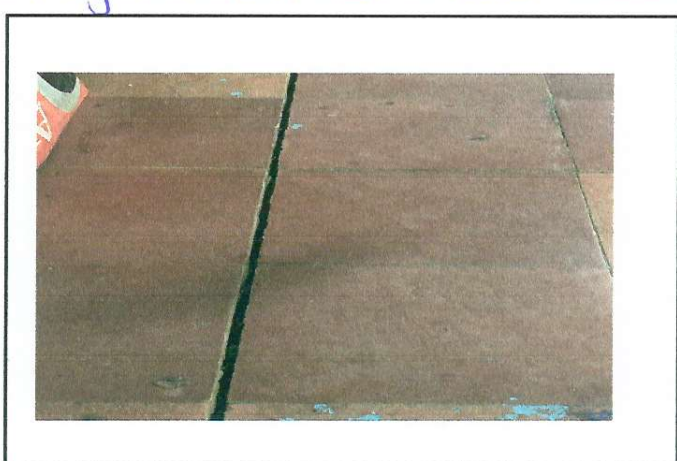
Foto 4: Mejoramiento de Pisos
