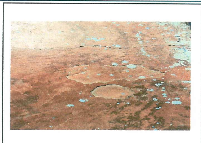
Foto 2: Mejoramiento de Pisos
