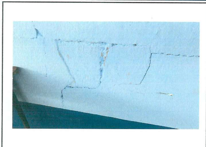
Foto 1: Reparación de repello y Cernido de Paredes
